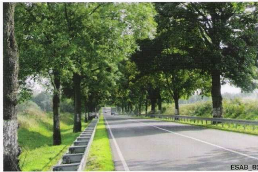
Bild 3: Beispiel für Schutzplanken bei Bäumen mit ausreichendem Abstand zum Fahrbahnrand
